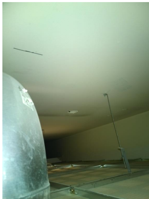
Kuva 5: Betonikatossa kiinnikkeitä ja rasioita
