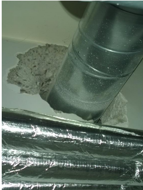
Kuva 7: Läpivienti käytävän suuntaan
