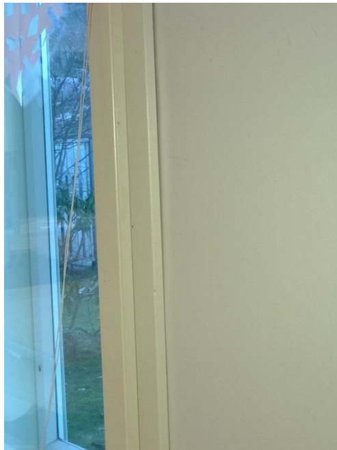
Kuva 9. Mahd. vuotoreitti ikkunan pielen kautta
