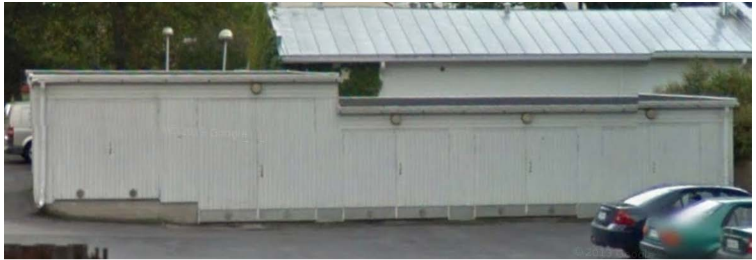
Garage- och servicebyggnaden på tomt 285.
