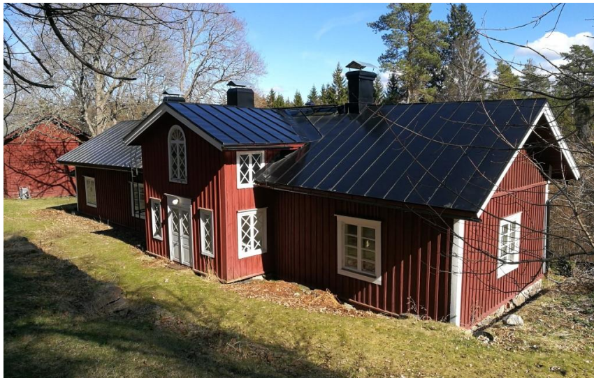
Valokuva 8. Kuva Gammelbackan päärakennuksesta.
