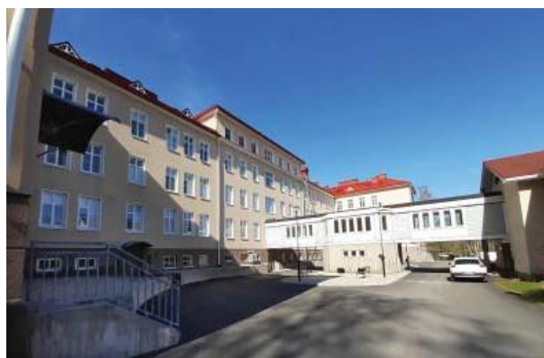
Kuva 24. Päärakennuksen sr-1(1) sisäpiha.
