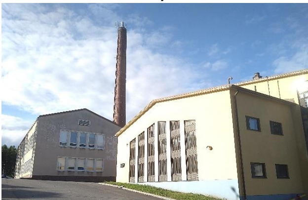
Kuva 22. Entinen Kosthålli sr-1(11) ja lämpökeskus sr-1(12).
