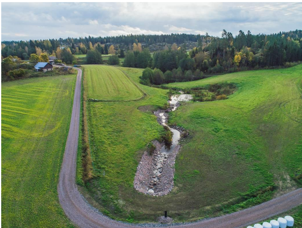
Kuva 7. Grabbackan eroosiosuojaustyöt valmiina (kuva: Multifoto).
