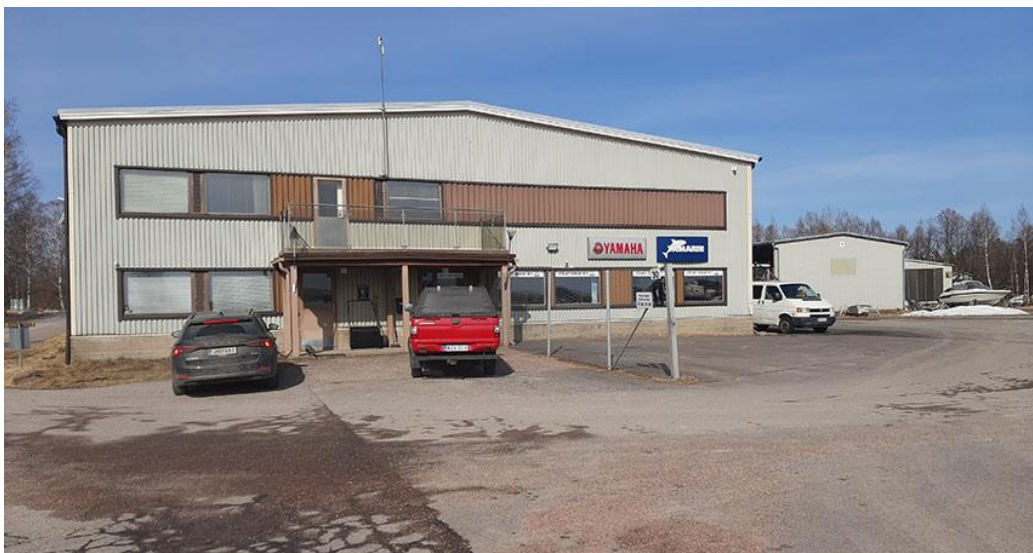
Den sydligaste hallen med kontorsbyggnad på tomt 2 i kvarter 9351.
