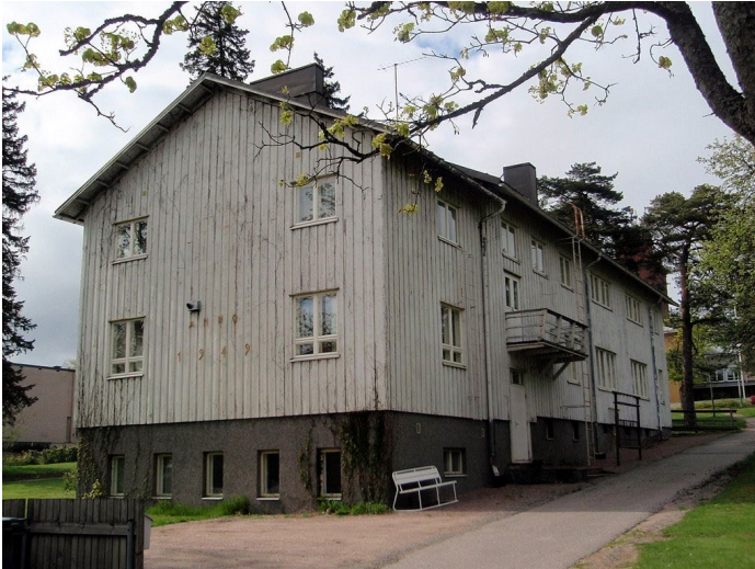
Bild 8. Ystadsgården sedd från Ladugårdsgatan.
