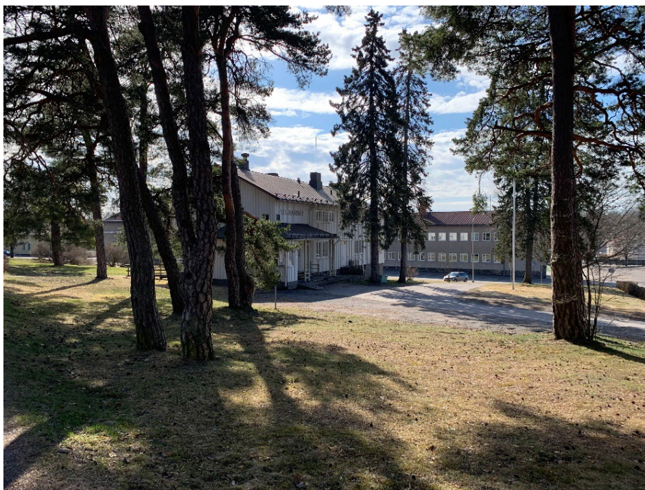
Bild 5. Ystadsgården sett från nordvästra hörnet.
