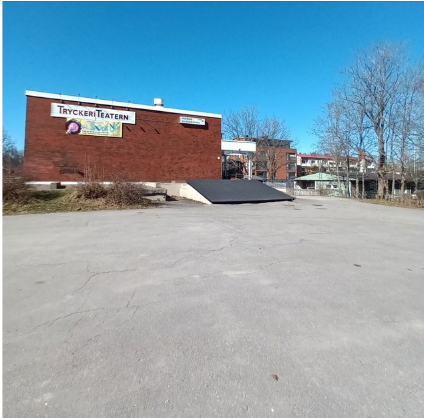
Kuva 2. Suunnittelualue on rakennettu ja suurelta osin päällystetty.
