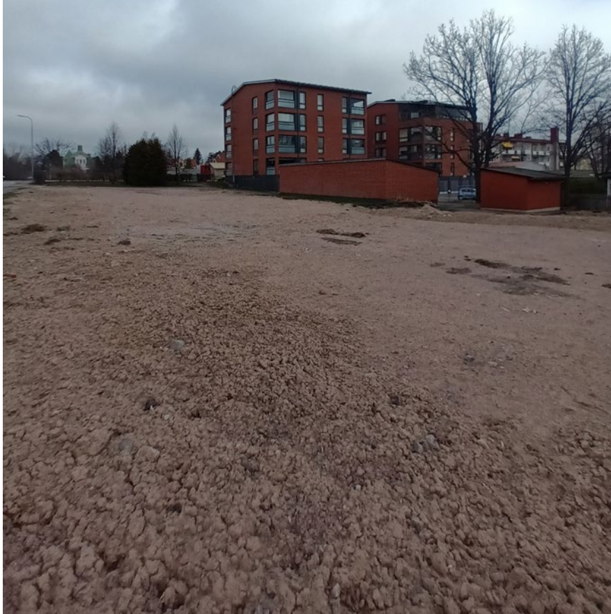
Kuva 3. Painotalo purettiin syksyllä 2022, kaava-alueelle jäänyt jätekatos näkyy kuvan oikeassa reunassa. Maanpinta ei ole enää päällystetty asfaltilla.
