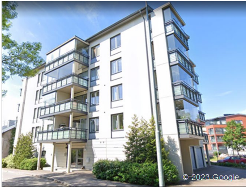
Kuva 7. Viisikerroksinen talo, joka sijaitsee Heikinkadun varrella samassa korttelissa, kun kaava-alue. Talo näkyy hyvin kaava-alueesta. Kuvassa oikealla näkyvät Keskuskadun nelikerroksiset rakennukset. (Kuva: Google Earth, 17.1.2023)
