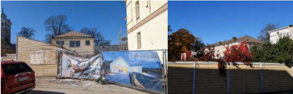
Suunnittelualue, julkisivu Isolle Kirkkokadulle (2023). Oikealla osa tontinrajalla sijaitsevasta rakennuksesta.
