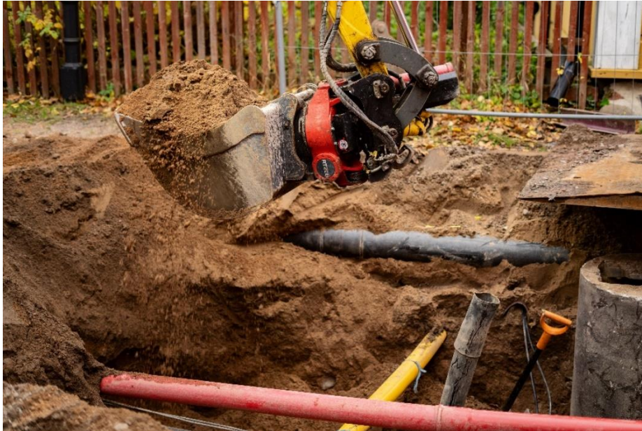
Kuva3 Liinakankurinkadun kunnallistekniikkaa, Tammisaari
