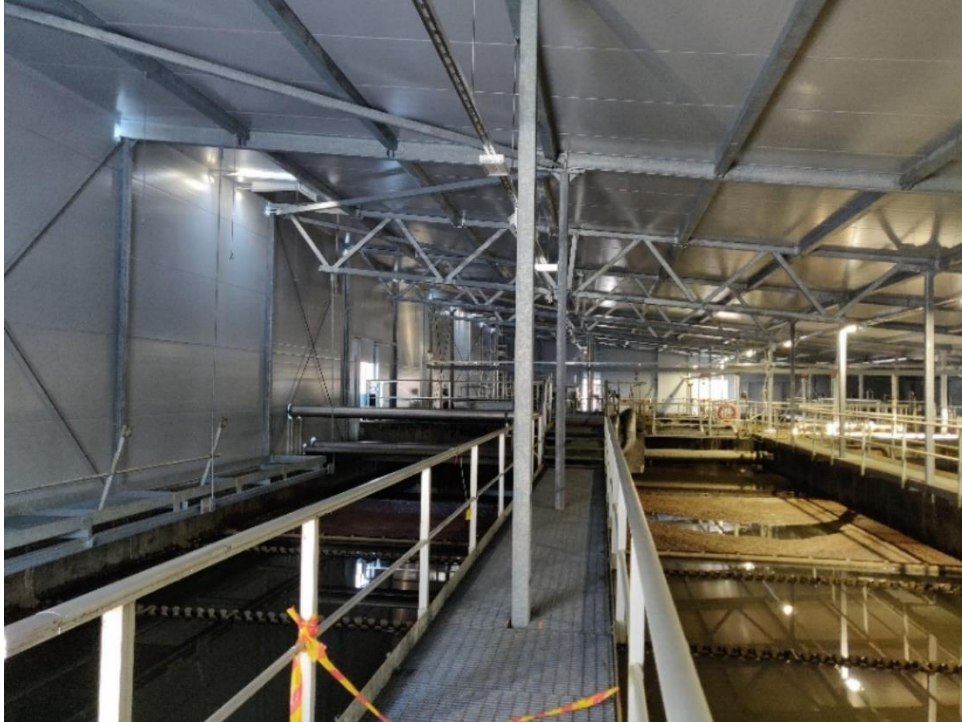
Kuva 5 Skeppsholmenin puhdistamon seinien ja katon rakennustyö on loppusuoralla
