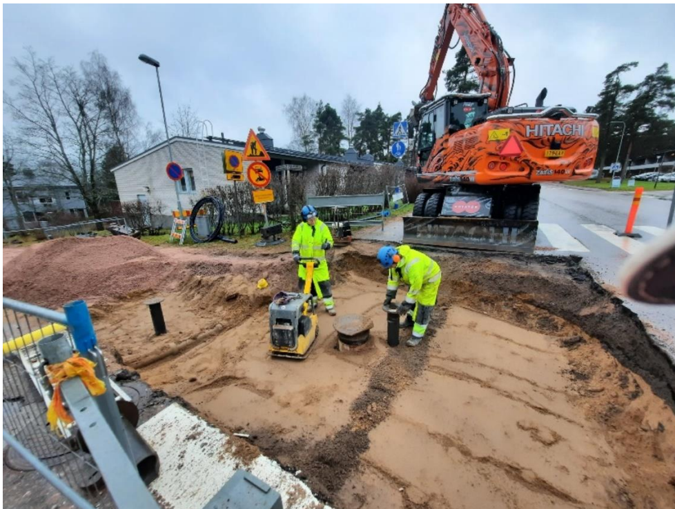
Kuva 4 Jussi ja René saneeraamassa johtoja Klockarsinkadulla, Karjaa
