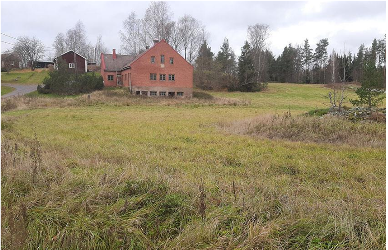
Kuva 2. Navetta on rakennettu poltetuista punatiileistä, katto betonitiilinen.
