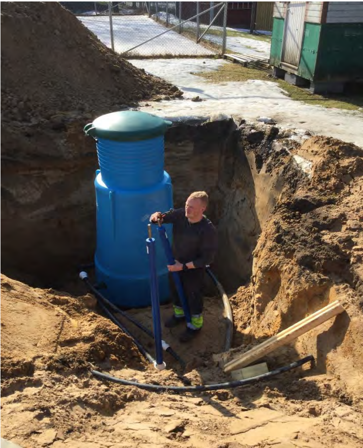
Installation av mätbrunn, tennisplan i Ekenäs, Robin Lindholm
