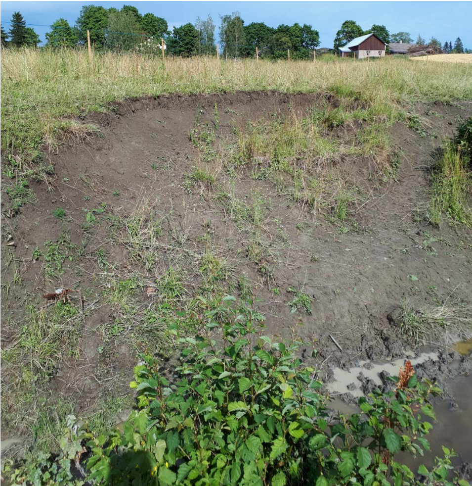
Kuva 4. Tuore luiskasortuma. Luiskat tulisi verhoilla esim. louheella, jolloin niiden stabiilitteetti paranisi.
