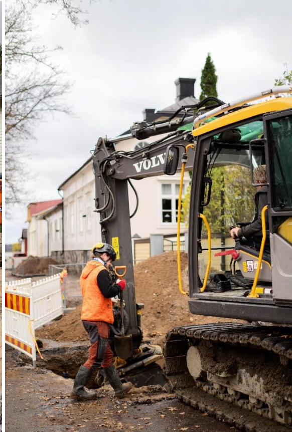
Eteläisen Rantakadun saneeraus, Tammisaari
