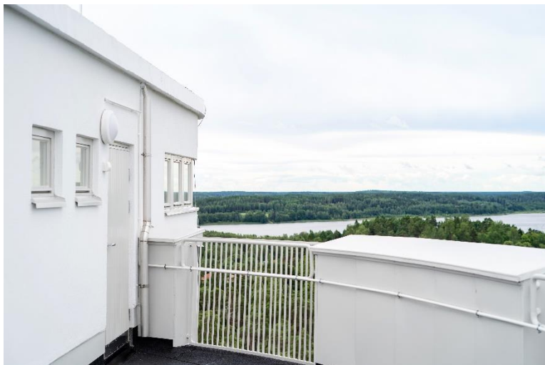
Näkymä Karjaan peruskorjatusta vesitornista
