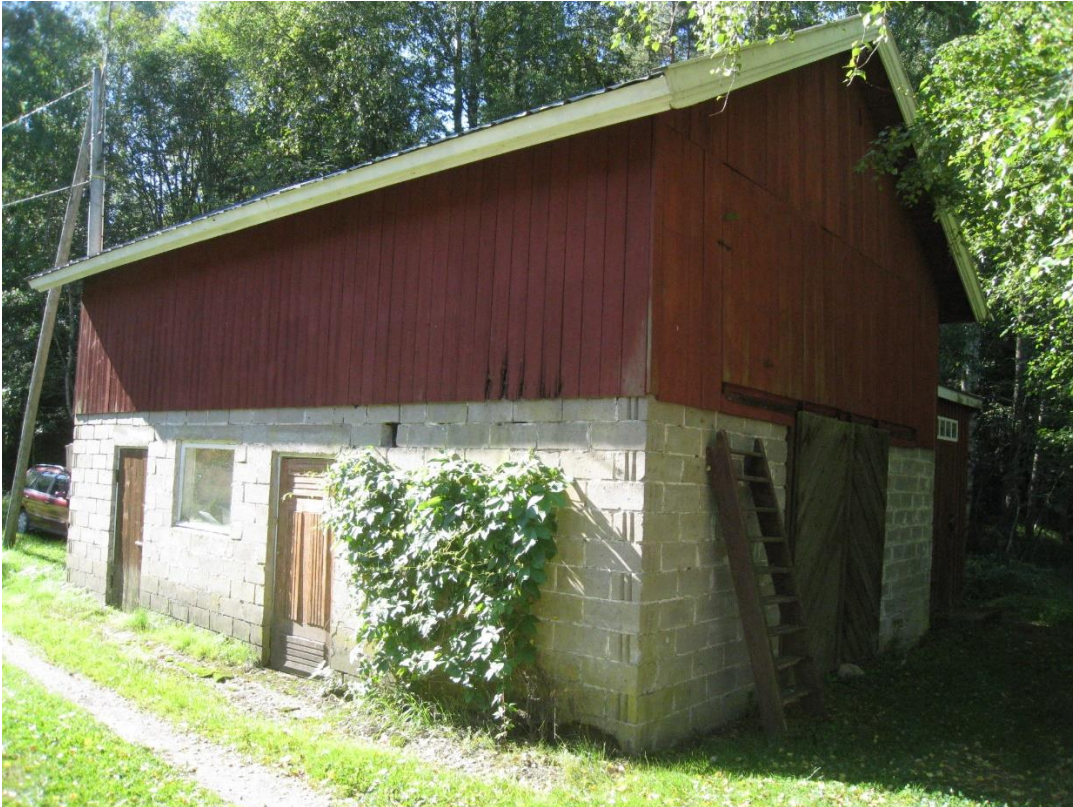
Bild 17: Gammal ekonomibygggnad på tomt 1. Foto taget från norr.
