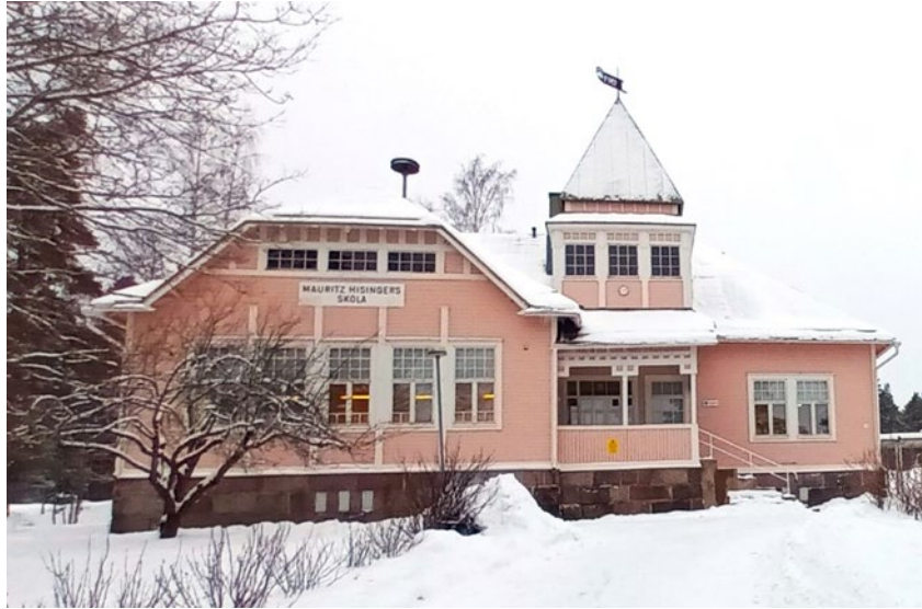
Kuva 13. Vanha koulurakennus vuodelta 1904 peruskorjattiin vuonna 1990.
