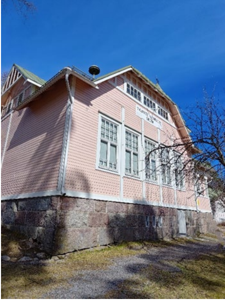
Kuva 8. Vanha koulurakennus vuodelta 1904 peruskorjattiin vuonna 1990.
