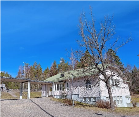
Kuva 9. Vuonna 1990 rakennettiin uusi koulurakennus vanhan koulurakennuksen viereen.
