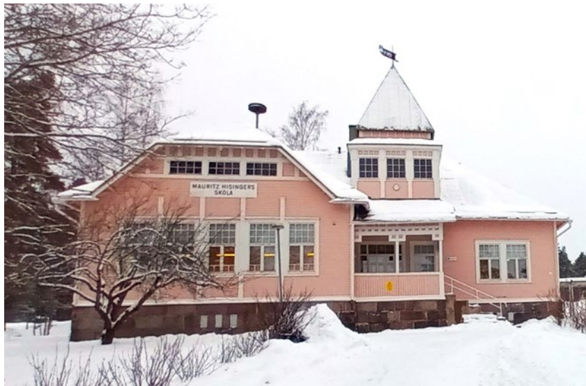
Kuva 11. Vanha koulurakennus vuodelta 1904 peruskorjattiin vuonna 1990.
