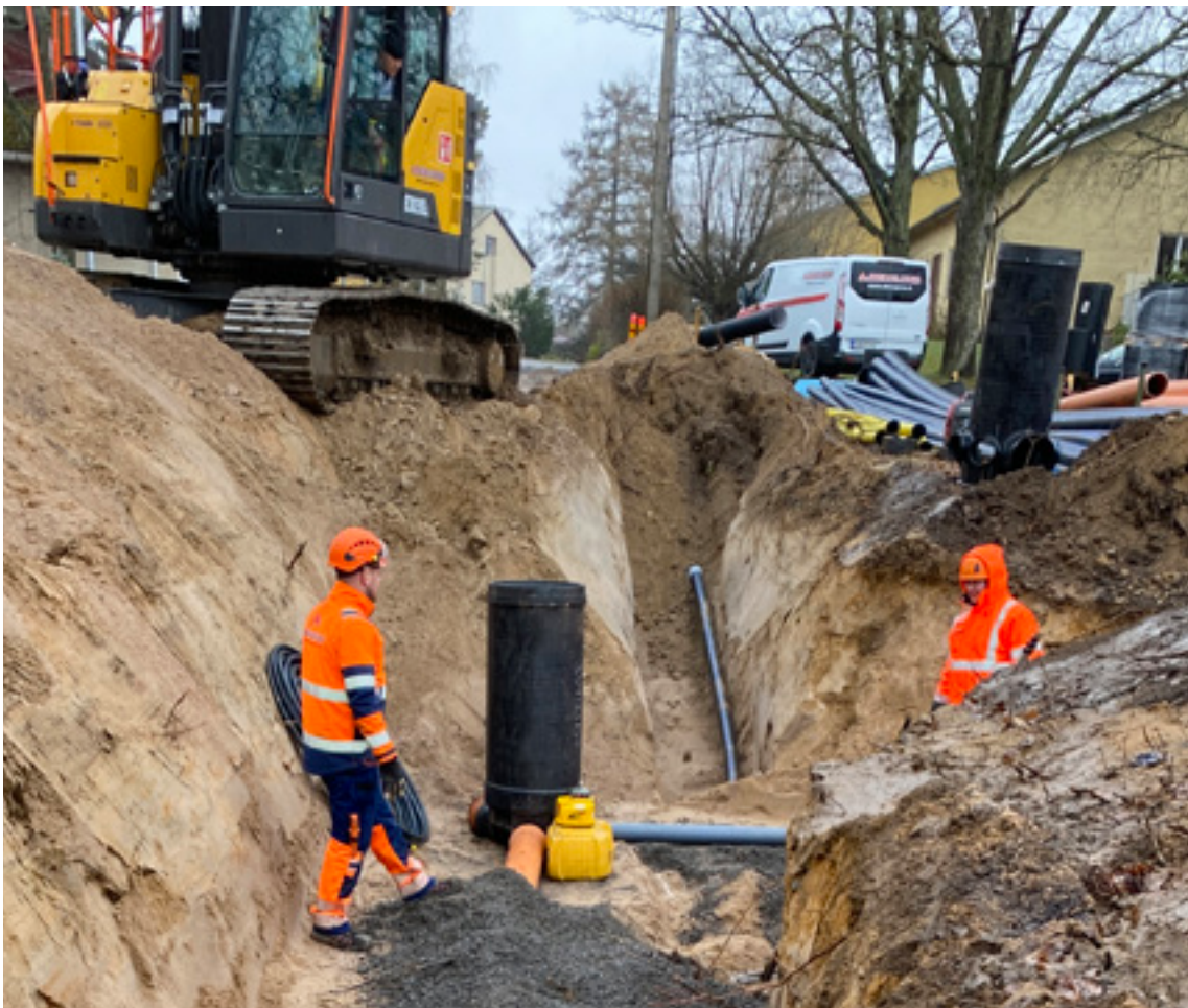
Saneeraustyöt Esikunnankadulla. | Kuva: Mats Gerkman
