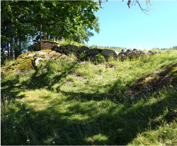
Kuva 16. Koillisessa, kallioiden päällä sijaitsevat kivi- ja betoniperustukset. Kuvattu lännestä. Kuva: Jerry Möller, Maanala Oy.
