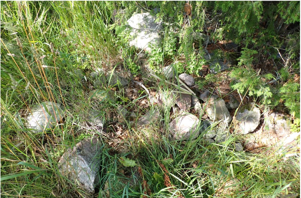
Kuva 22. Perustusten luoteispäätyä kuvattuna idästä. Kuva: Jerry Möller, Maanala Oy.
