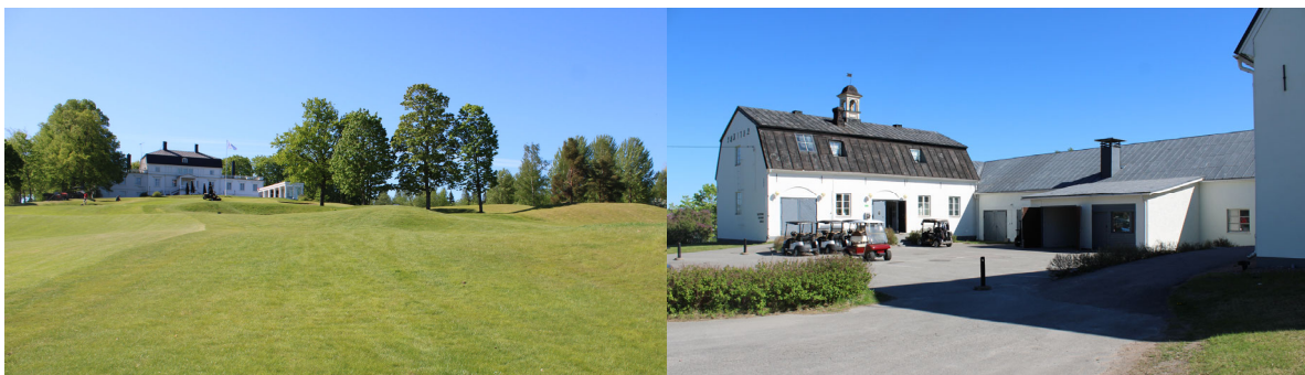
Bild 20 och Bild 21. Ovan herrgårdens huvudbyggnad från norr enligt tillfartsvägen. Till höger, den putsade stallbyggnaden är från 1782
