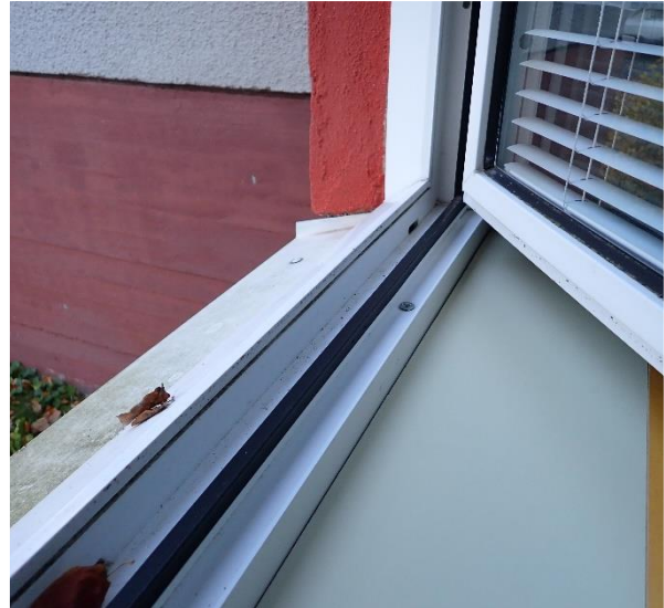
Kuva 77 Ikkunoiden toimivuudessa ei havaittu merkittäviä puutteita.
