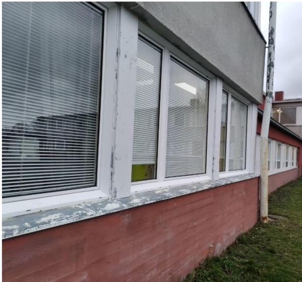
Kuva 79 Alkuperäisen osan nauhaikkunoiden välissä on kotelorakenteita, joihin kohdistettiin tutkimuksia.
