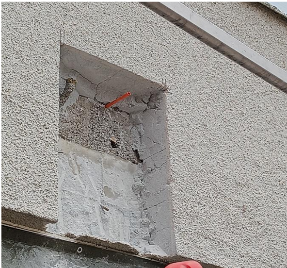
Kuva 67 Alkuperäisen osan kevytbetonisen ulkokuoren kuntoa ja kiinnittävyyttä tarkasteltiin rakenteeseen tehdyn avauksen kautta.
