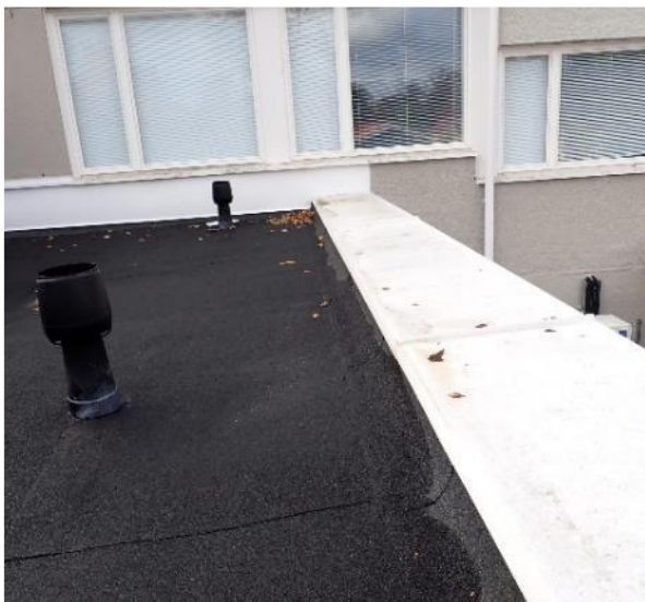
Kuva 90 Keittiösiiven katteena on bitumikermi.
