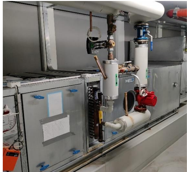
Kuva 128 Vuoden 1992:n ilmanvaihdonkone. (TK2.2)
