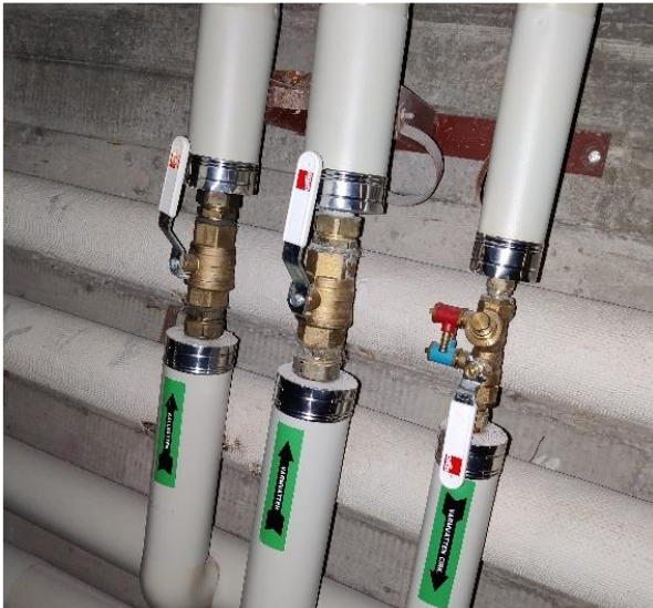
Kuva 123 Uusittuja käyttövesiverkoston putkia ja säätöosia.
