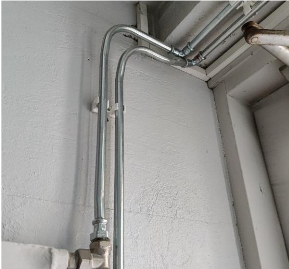
Kuva 117 Uusittuja lämpöjohtoja.
