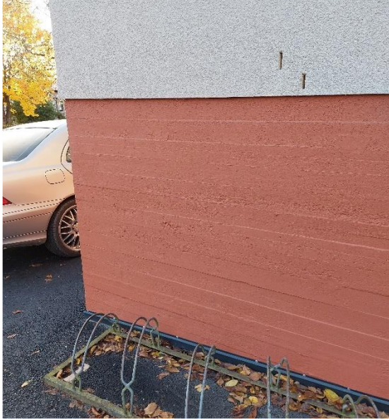
Kuva 22 Keittiön laajennusosan sokkelirakenne. Sokkelin alaosassa on patolevytys.
