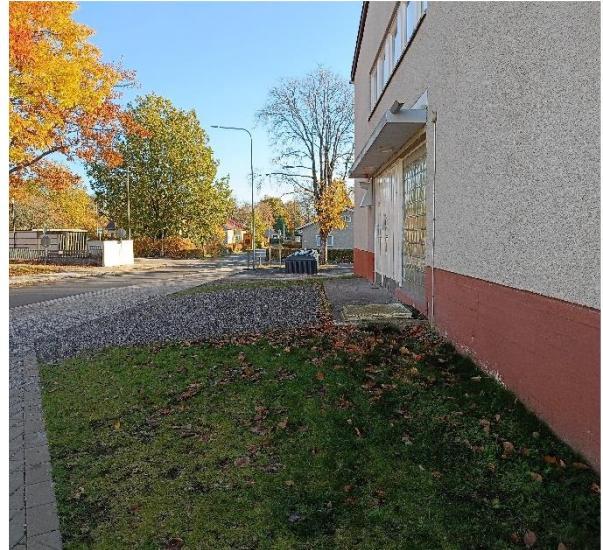
Kuva 4. Ruokasalin edustalla maanpinta on tasainen rakennuksen vierustalla.
