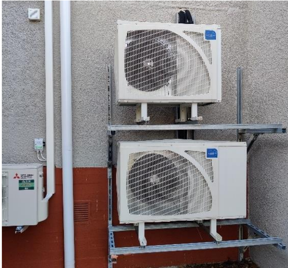
Kuva 133 Jäähdytysjärjestelmän ulkoyksiköt.
