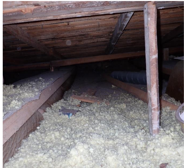
Kuva 99 Yleiskuva B-osan yläpohjatilasta.
