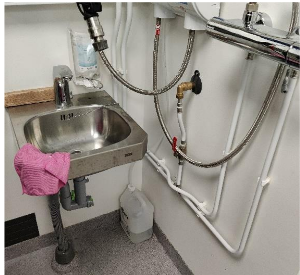
Kuva 126 Yleiskuva siivouskomeron vesikalusteista.
