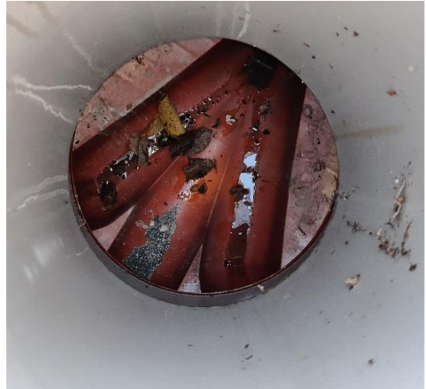
Kuva 122 Näkymä viemäriin tarkastuskaivosta.
