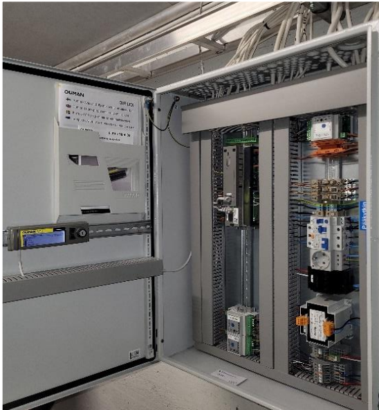
Kuva 163 Uusi Oumanin säätölaitekeskus.
