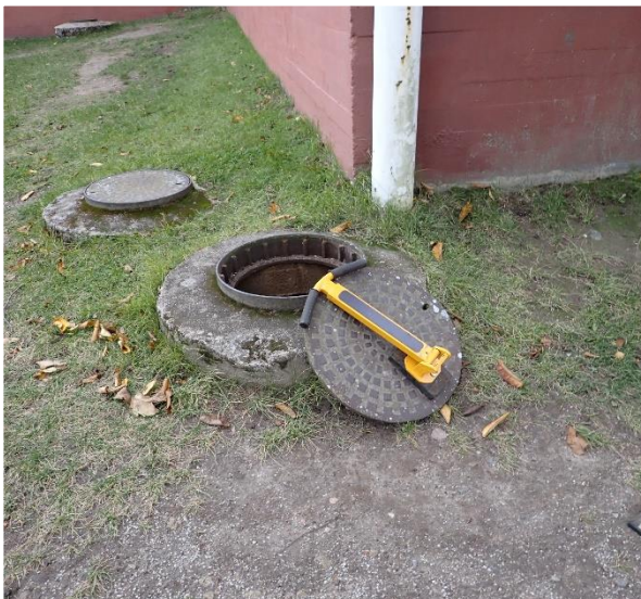
Kuva 12 Salaojan tarkastuskaivo liikuntasalin kaakkoiskulmauksessa.
