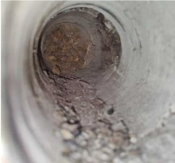
Kuva 26 Pääosa alkuperäisten sokkelirakenteiden eristekerroksista on toteutettu korkkieristeellä.
