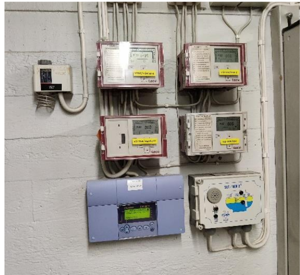
Kuva 111 Kaukolämpöpaketin ohjausyksiköt.
