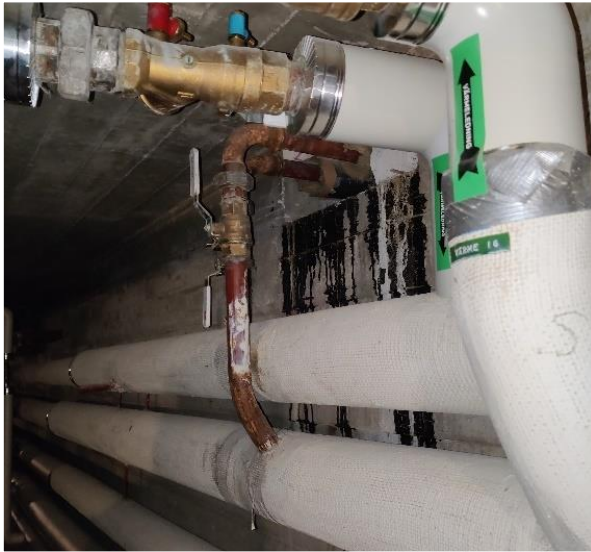
Kuva 115 Osittain uusittuja lämpöjohtoja putkikanaalissa.
