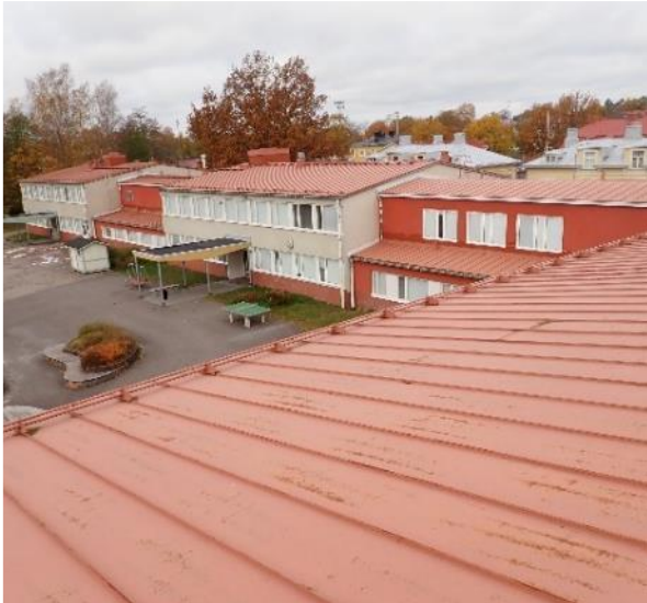
Kuva 84 Yleiskuva A-osan vesikatolta.
