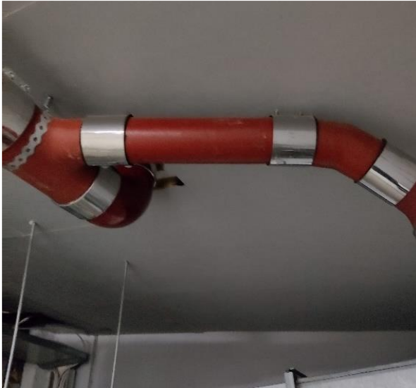
Kuva 121 IV-konehuoneessa uusittu valurautaviemäri.
