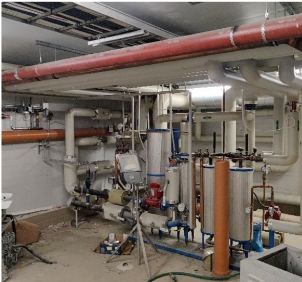
Kuva 110 Kiinteistön kaukolämpöpaketti.
