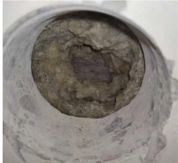
Kuva 27 Laajennusosalla sokkelinhalkaisuna on mineraalivillaa.
