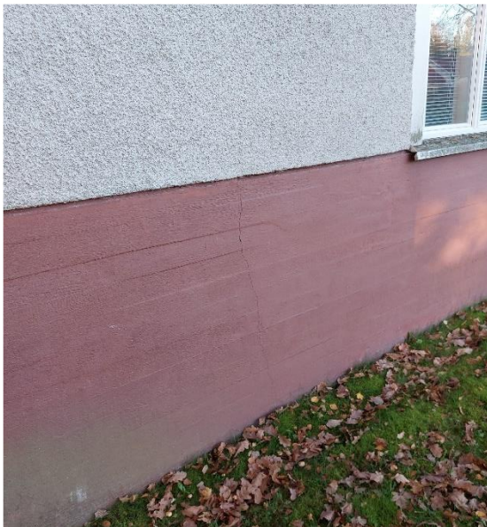
Kuva 20 Pystyhalkeama betonisokkelissa
