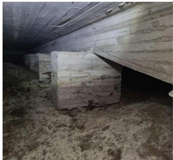
Kuva 17 Liikuntasalin alapuolella olevia betonisia pilarianturoita.
