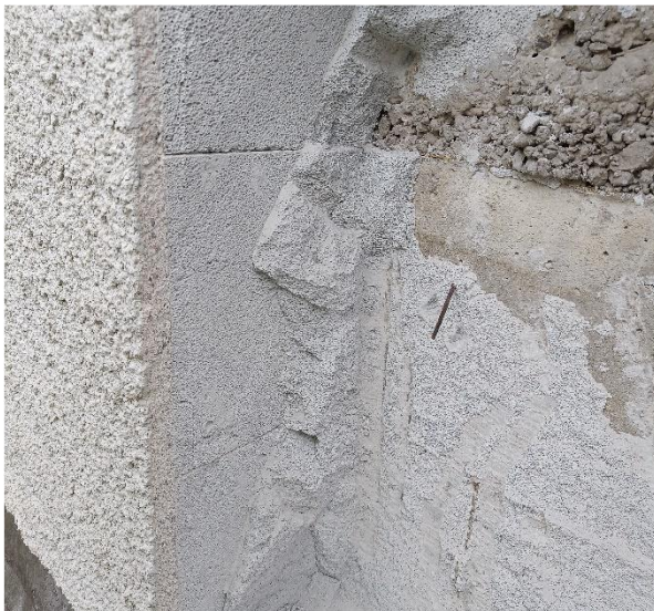
Kuva 71 Kevytbetoniharkot ovat rakennetarkasteluiden perusteella hyvin kiinni kantavassa betonirakenteessa eikä puutteita havaittu.
