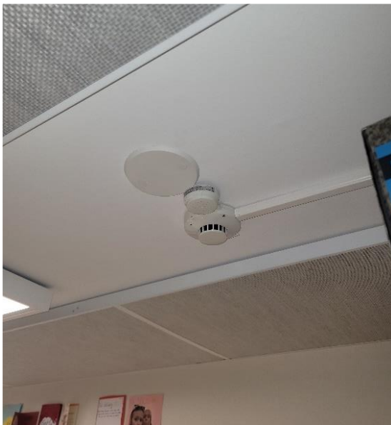
Kuva 173 Paloilmasin käytävällä.
