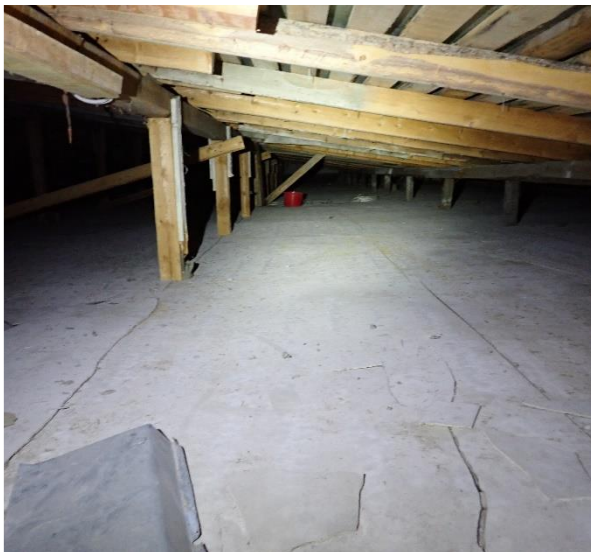
Kuva 102 Yleiskuva alkuperäisen A-osan yläpohjatilasta.
