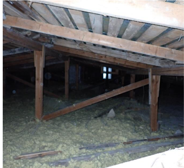
Kuva 105 Yleiskuva B-osan yläpohjatilasta.
