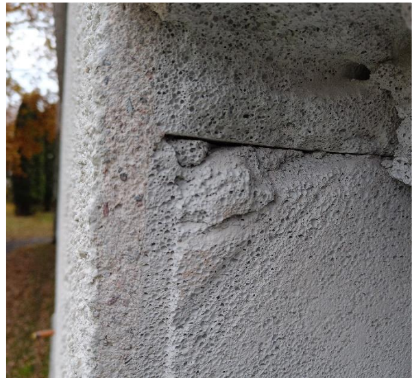
Kuva 68 Kevytbetoniharkkojen pinnassa on rappauskerros.
