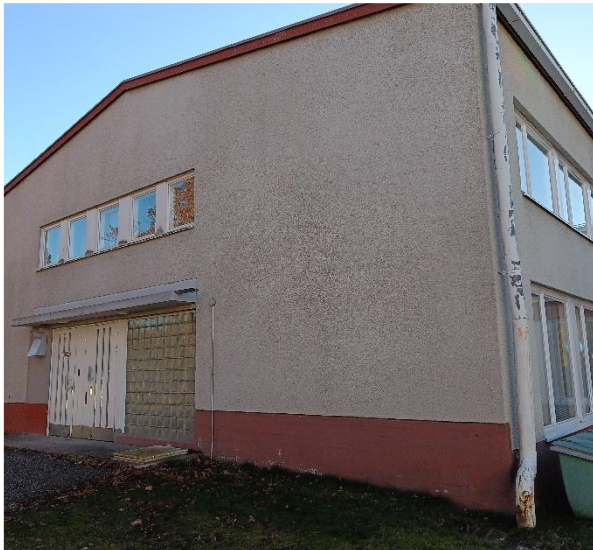
Kuva 61 Alkuperäisen osan julkisivut ovat kevytbetoniharkkojen pintaan rapattuja.
