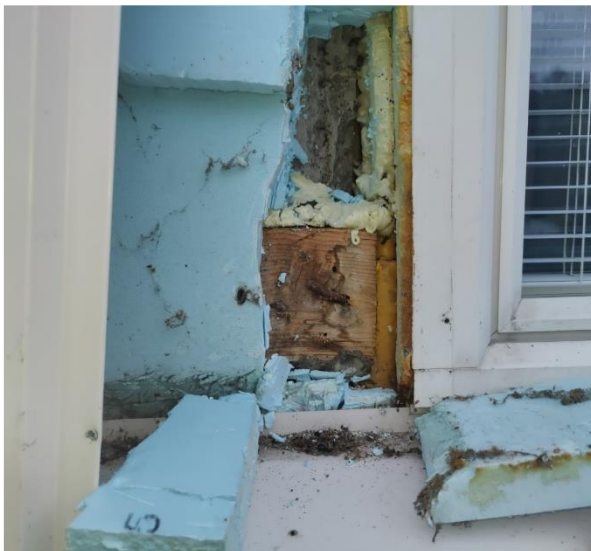
Kuva 81 A-osalla nauhaikkunoiden pellityksen taustan eristystä on uusittu xps-levyllä. Puurakenteissa havaittiin kosteusjälkiä.
