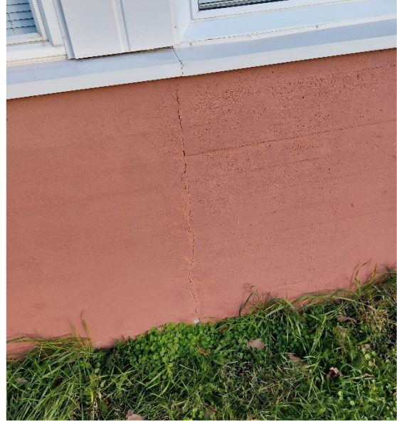
Kuva 23 Pystyhalkeama sokkelissa
