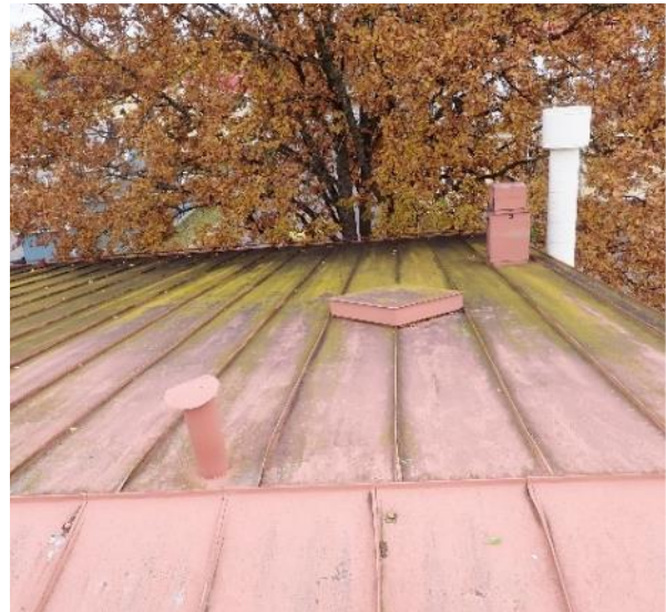
Kuva 89 C-osan vesikatteen pinnalla on tummentumaa/sammalkasvustoa.
