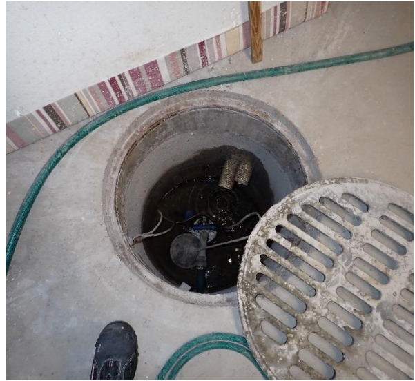
Kuva 15 Lämmönjakuhuoneessa sijaitseva pumppukaivo.
