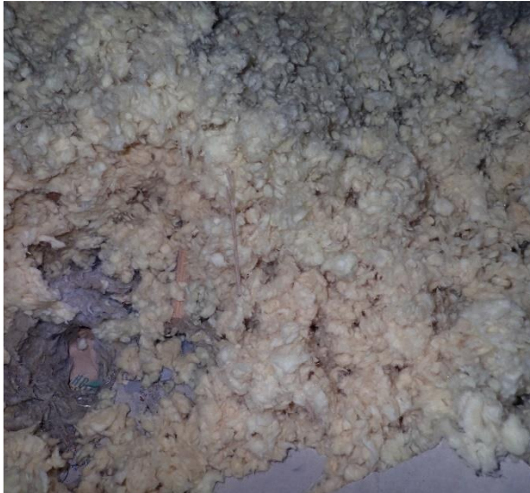
Kuva 100 Yläpohjaeristeenä on alkuperäisillä osilla mineraalivillaa. Villan alla näkyy kuvassa sementtikuitulevyä.
