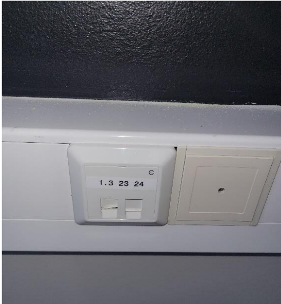
Kuva 159 Telerasia opettajainhuoneen johtokanavas-sa.
