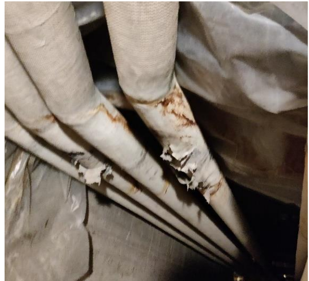
Kuva 124 Rikkoutuneita putkieristeitä.
