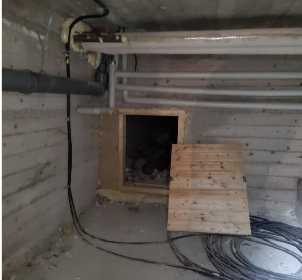
Kuva 39 Tekniikkatunnelin kautta on kulku A-osan alapohjatilaan.
