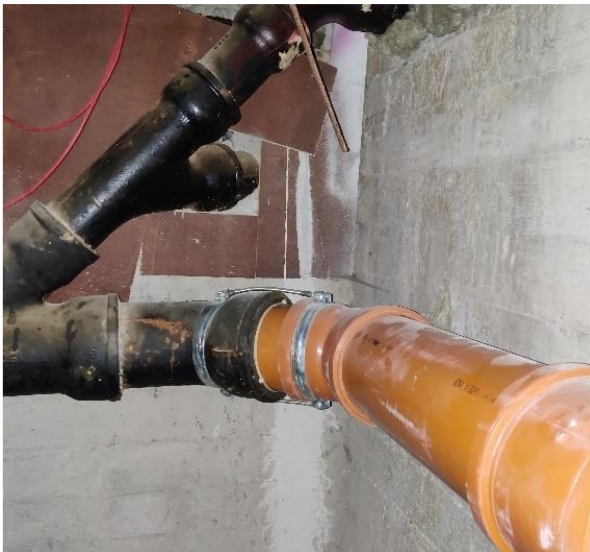
Kuva 119 Vanhaa valurautaviemäriä korjattu muovisella viemäriputkella.
