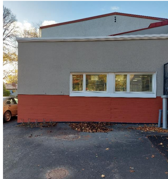
Kuva 62 Laajennusosan julkisivua keittiön kohdalla.
