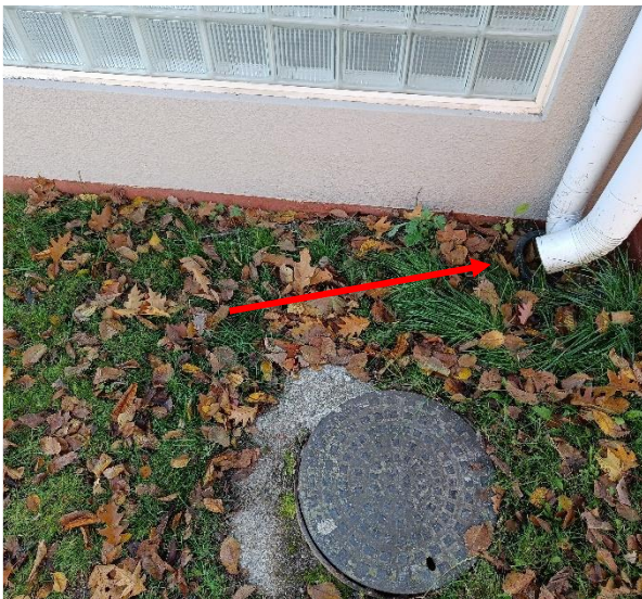
Kuva 5 Sadevedet on ohjattu osittain loiskekaukaloihin. Loiskekaukalossa on lehtiä, joka heikentää järjestelmän toimivuutta.
