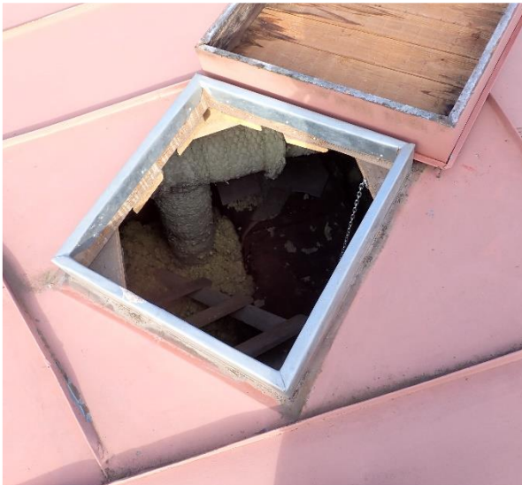
Kuva 98 Alkuperäisten rakennusosien yläpohjatiloja tarkasteltiin pistokoeluoontoisesti kattoluukkujen kautta.
