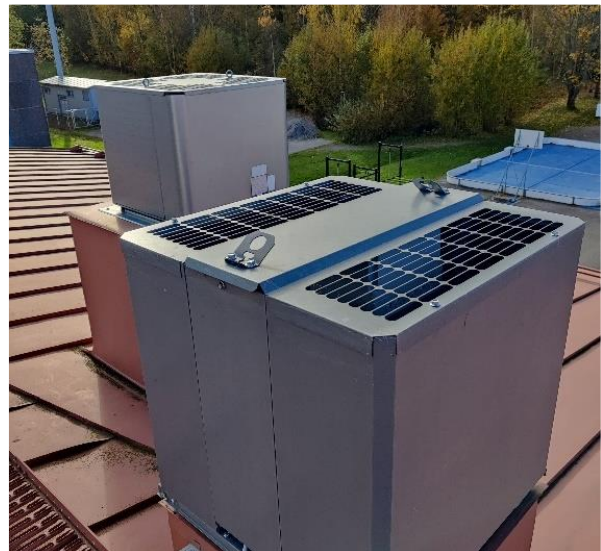
Kuva 130 Uusittuja huippumureita.
