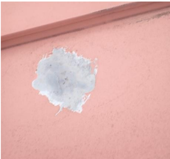
Kuva 86 C-osan vesikatetta on paikattu.
