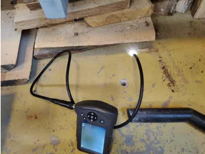
Kuva 2 Rakenneporaus. Rakenteita tarkasteltiin kameralla.
