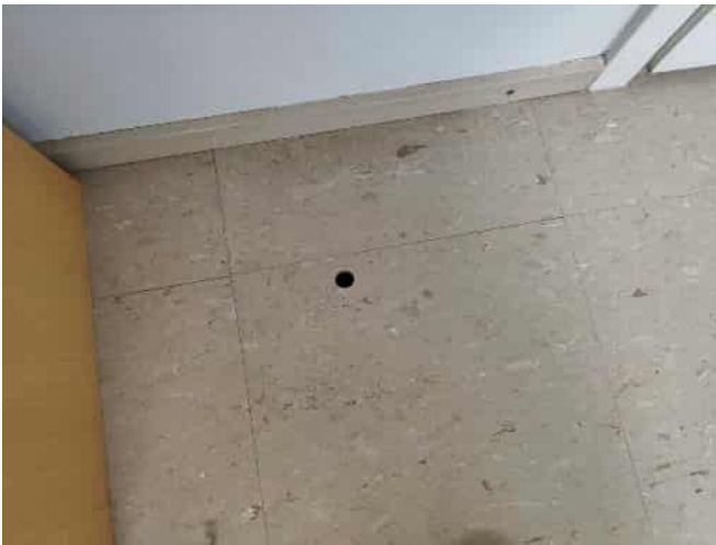
Kuva 1 Tutkimustehtiin rakennekameralla porareijästä
