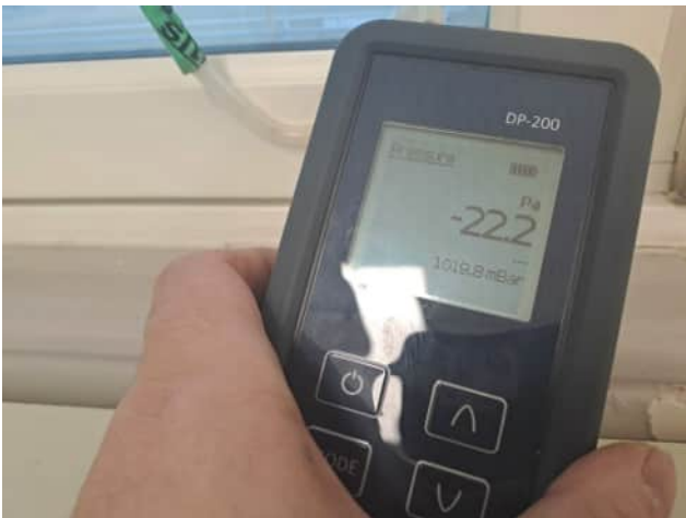
Paine-ero tarkastettiin kuvassa näkyvällä paine-ero mittarilla.
