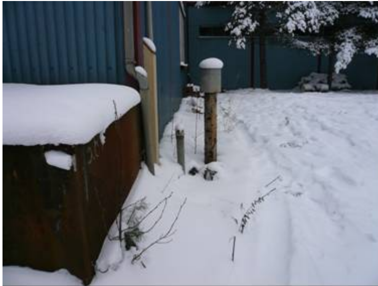
Puhdistamon itäpääty. Kuvan vasemmassa reunassa kemikaalivarasto sekä keskellä öljysäiliön syöttöputki
