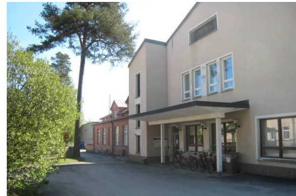
Kuva 72 Rakennus M pääovi, takana vanha punatiilinen "kosthållin" pääty.
