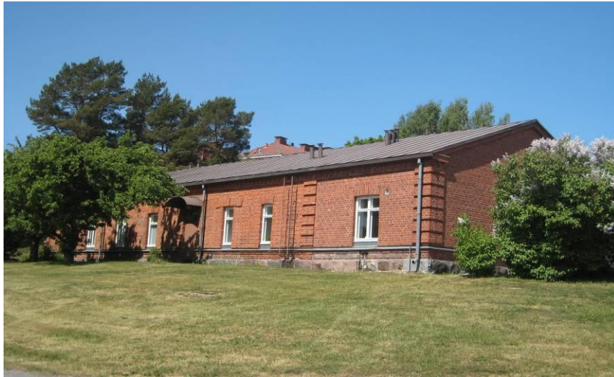
Kuva 58 RakennusH kuvattuna eteläpuolelta.
