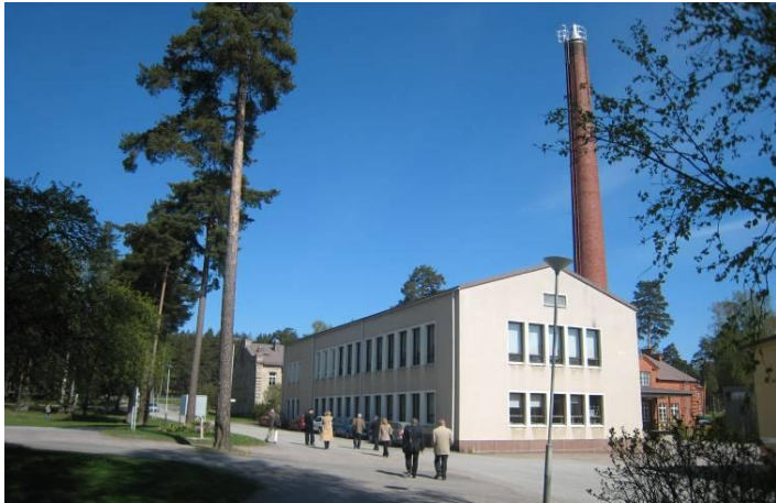
Kuva 71 Rakennus L päärakennuksen suunnasta nähtynä.
