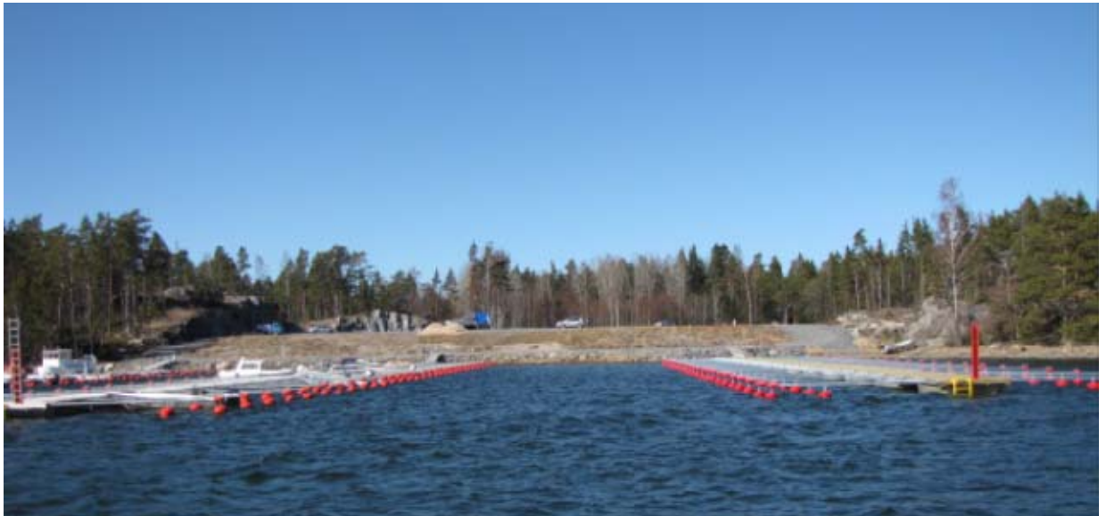
Bild 2. Vy över byggnadsplatsen från den pontonbrygga som ligger längst ut.
