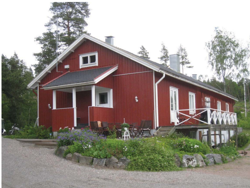
Bild 5. Befintligt byggnadsbestånd: 3a.
