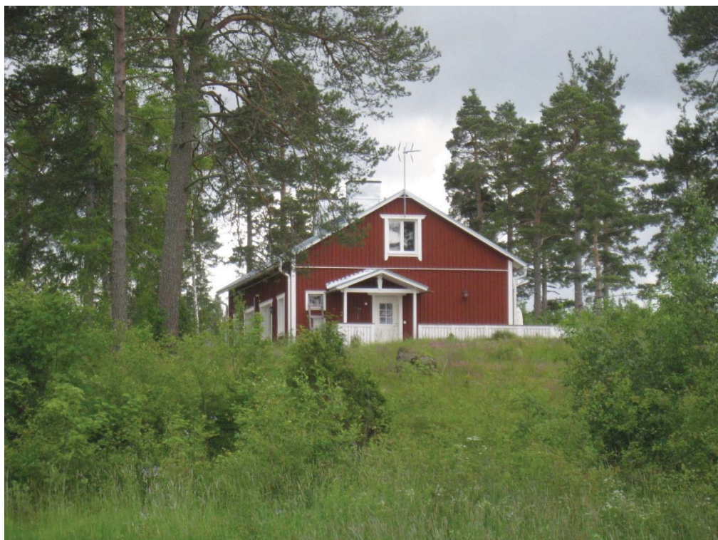
Bild 5. Befintligt byggnadsbestånd: 6b.
