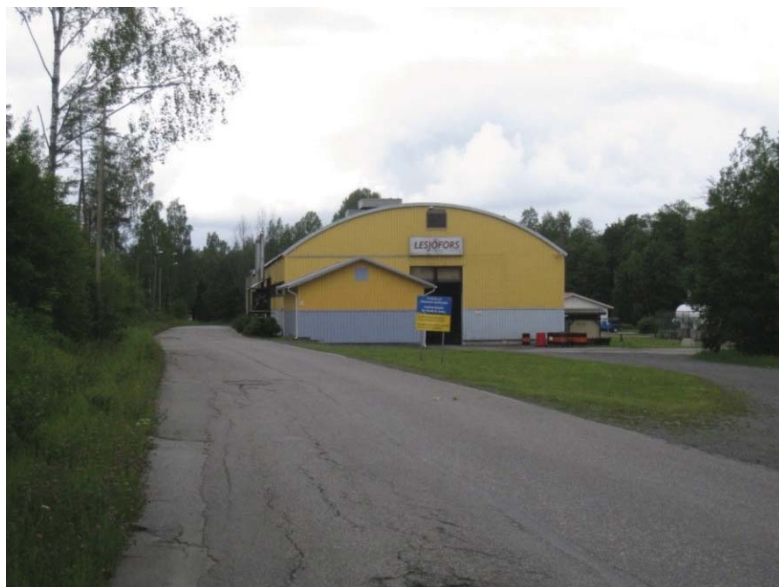
Bild 3a: Lesjöfors industrihall från öster. Valsverksvägen längs hallens södra vägg (till vänster på bilden).
