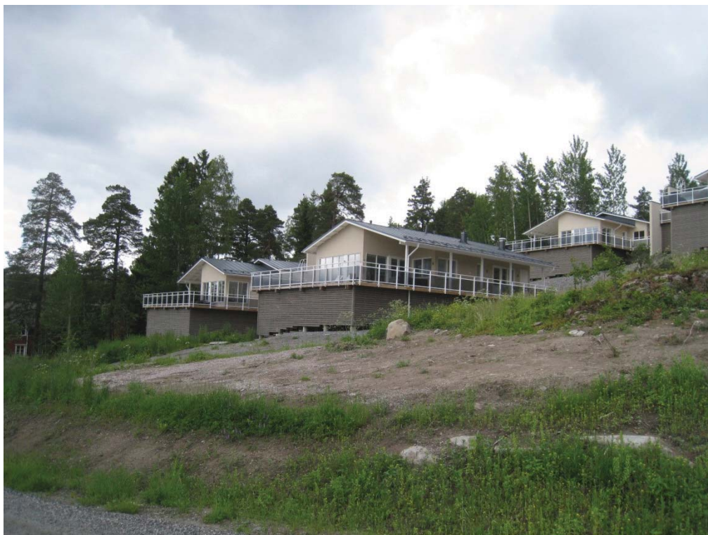
Bild 5. Befintligt byggnadsbestånd: 6a.
