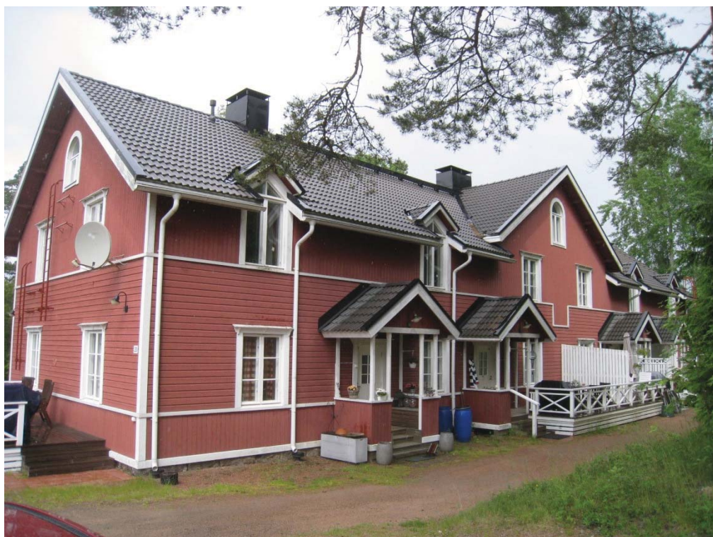
Bild 5. Befintligt byggnadsbestånd: 1b.
