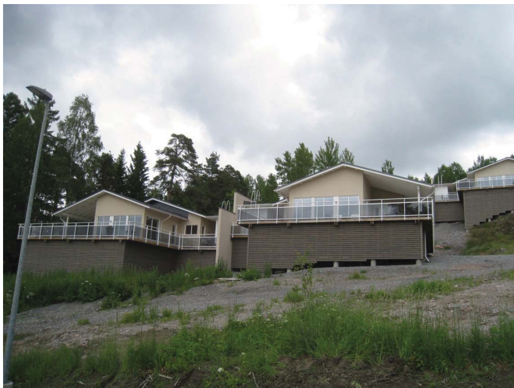
Bild 5. Befintligt byggnadsbestånd: 8b.
