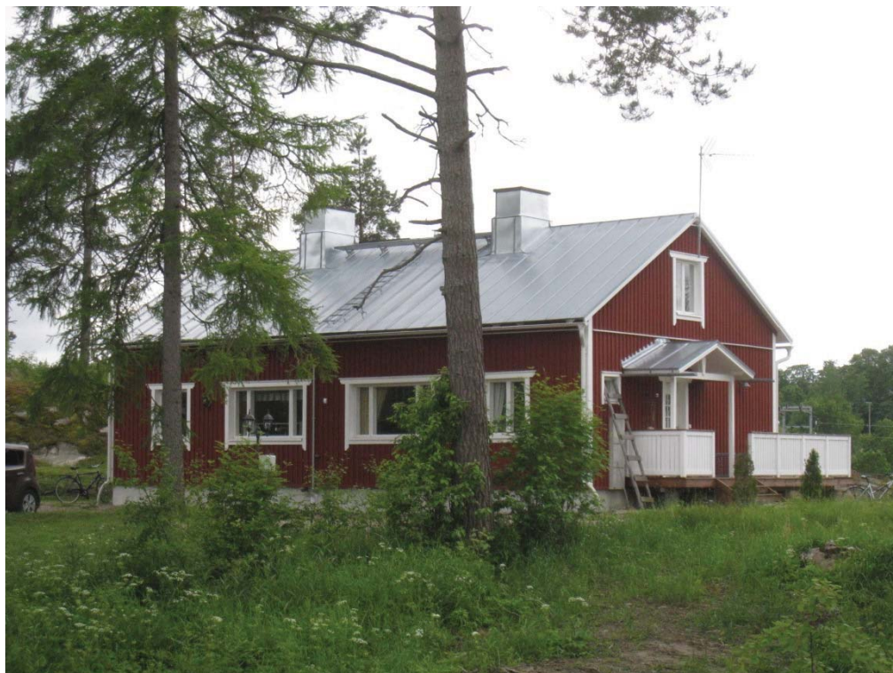
Bild 5. Befintligt byggnadsbestånd: 6a.
