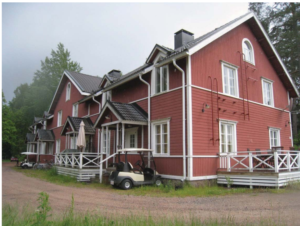
Bild 5. Befintligt byggnadsbestånd: 1a.
