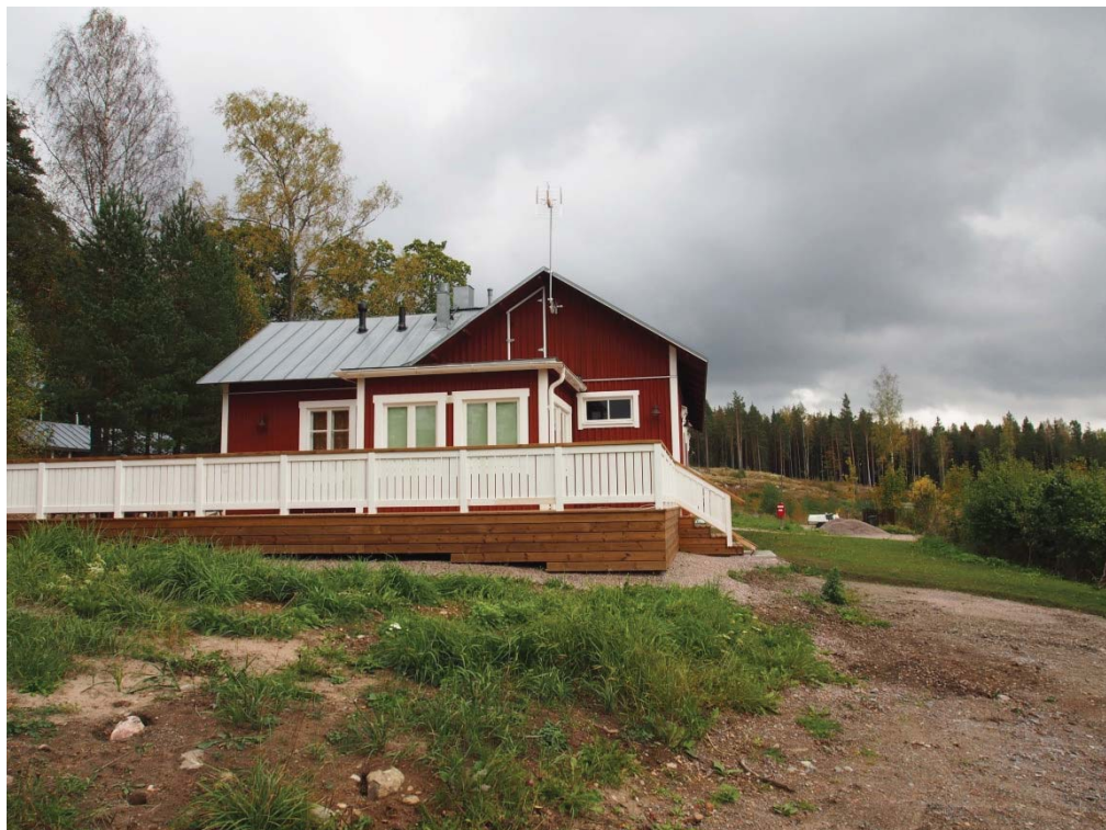
Bild 5. Befintligt byggnadsbestånd: 2b.
