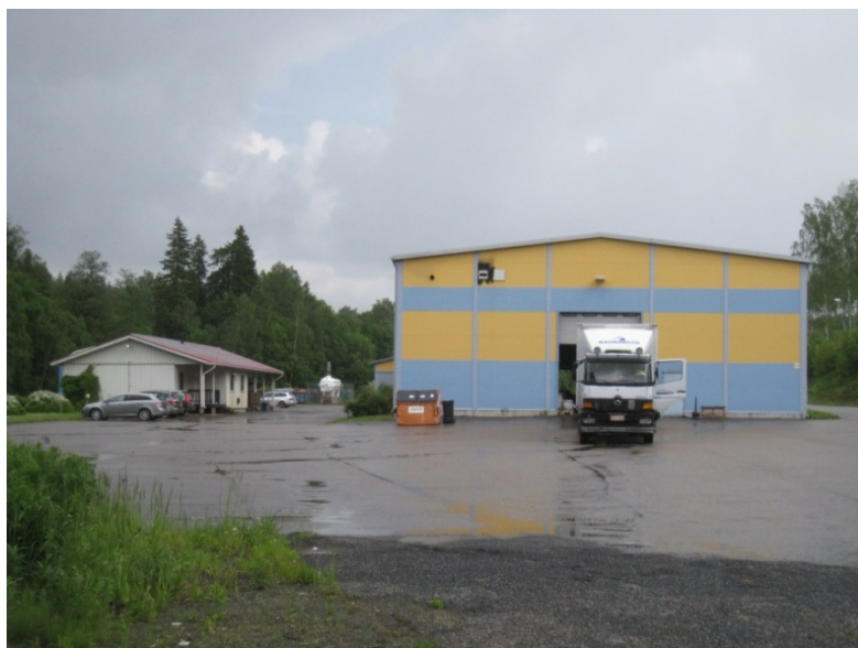
Bild 3b: Lesjöfors industrihall från väster. Valsverksvägen längs hallens södra vägg (till höger på bilden).
