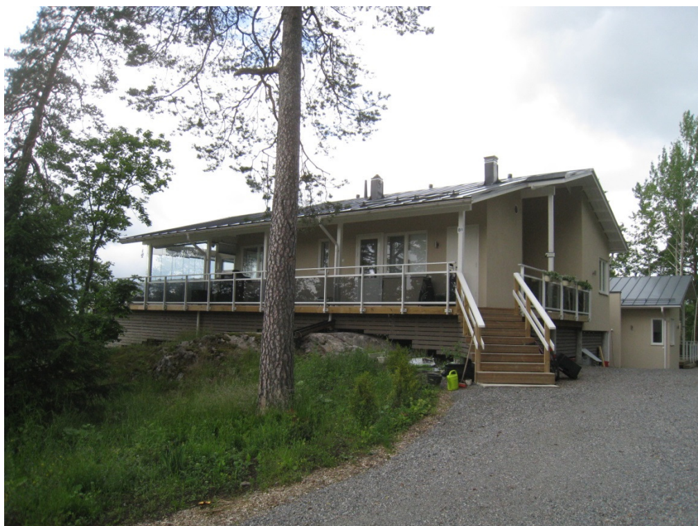
Bild 5: Befintligt byggnadsbestånd: 8c.
