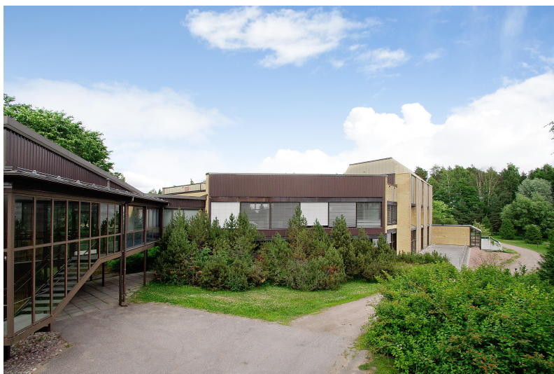
PÄÄRAKENNUS LOUNAASTA / HUVUDBYGGNAD FRÅN SYDVÄST
