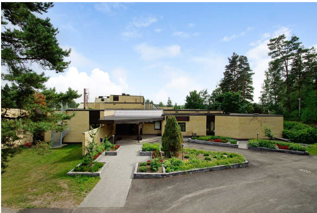
Päärakennuksen pääsisäänkäynti. Kuva rakennuksen pohjoispuolelta.
