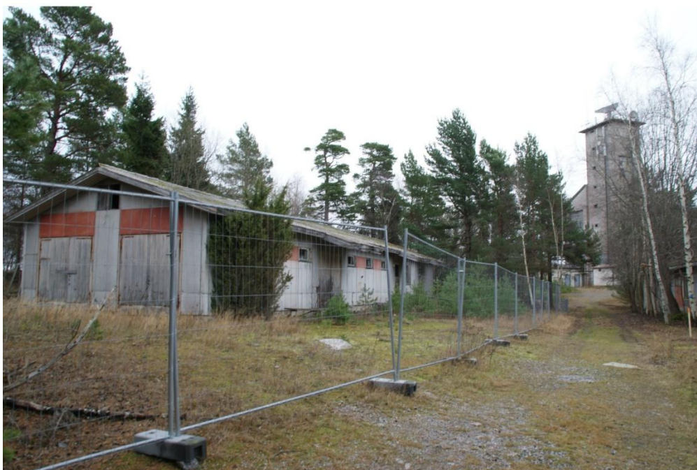
Vesitornin, konttorin ja verstarakennuksen muodostama rakennuskokonaisuus laajennettuna poratornin ympäristön rakennuksiin.
