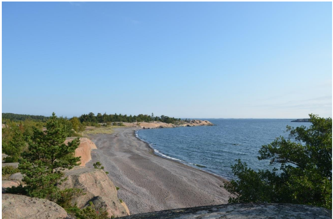
Bild 12. Fladan på den sydöstra sidan av ön fylldes igen med krossavfall från gruvan. På så sätt bildades ett grusfält och en strand. (Bild FCG 2014)
