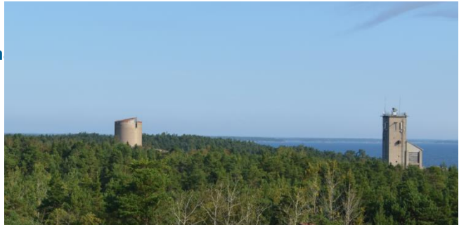
Bild 10. På Jussarö finns gamla byggnadsgruvverksamhet. (Bild FCG 2014)
