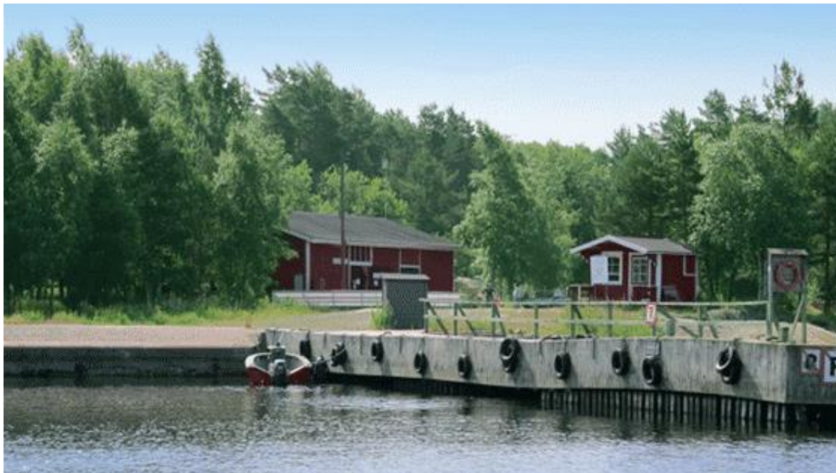
Bild 2. Byggnader vid Jussarö båthamn. (Bild Lotta Söderlund, www.jussaro.net )
