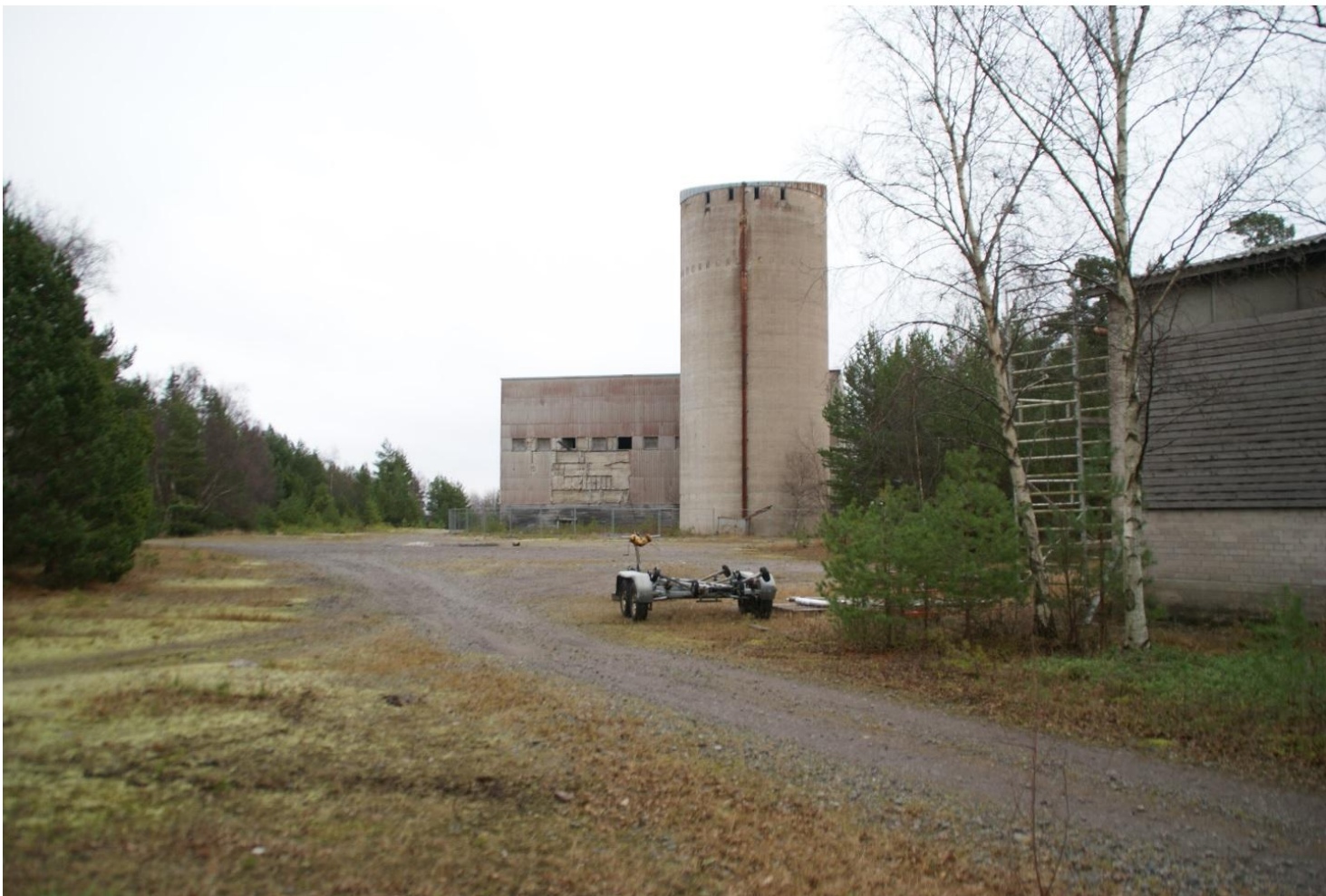
Konttorin, vesitornin ja verstarakennuksen muodostama rakennuskokonaisuus
